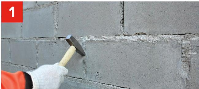
**1** Перед утеплением стены необходимо подготовить. Удалить осыпающуюся штукатурку, срезать выступающие части (гвозди, арматура) и выровнять поверхность штукатурными составами.
