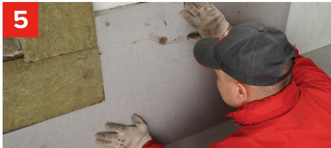
**5** Для качественной приклейки плит придерживаются следующего правила: после нанесения клеевого раствора плиту прикладывают к месту установки с небольшим смещением, и затем с нажатием сдвигают до места установки.
