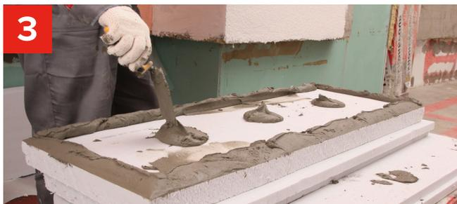
**3** Клеевой состав наносится на поверхность плиты сплошным слоем с помощью зубчатого шпателя либо полосой по периметру и несколькими «маяками» по центру. Способ нанесения зависит от ровности основания. Площадь клеевого слоя должна быть не менее 40% от площади плиты.
