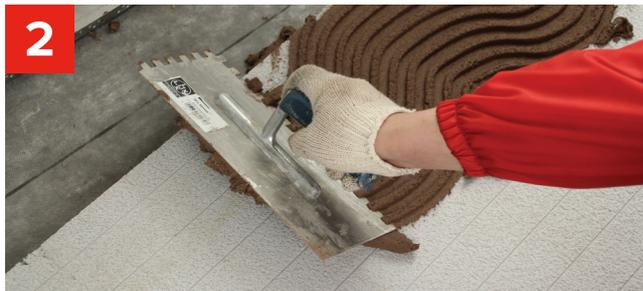
**2** На подготовленную поверхность приклеиваются плиты XPS ТЕХНОНИКОЛЬ CARBON ECO FAS. В качестве клеевых составов используются полимерцементные смеси, либо клей-пена для пенополистирола.
