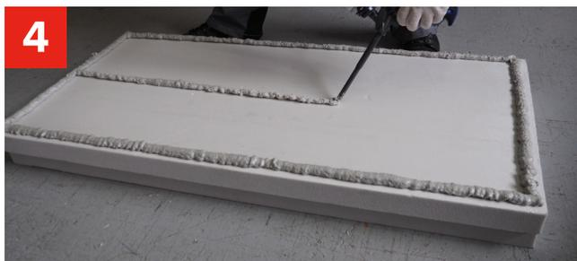
**4** Клей-пена для пенополистирола наносится по периметру плиты и одной полосой по центру. Ширина полосы нанесения 2-3 см. После нанесения клей-пены для пенополистирола необходимо выждать 5-7 минут до начала полимеризации, и только потом приклеивать плиту к стене.
